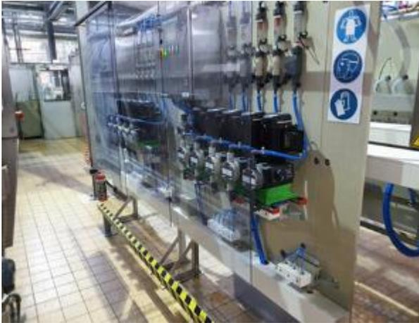
Neue Hygienerichtlinien machten die Erneuerung der Dosieranlage notwendig. Ziel dieser Dosieranlage ist es die Dosiermengen zu überwachen und eine Dosierung sicherzustellen. Bei Nichtdosierung werden die Waschstraßen automatisch gestoppt.
