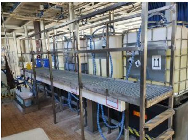
Zum Wechseln der Chemikalien ist wegen der höheren Auffangwannen ein Bedienungsteg notwendig geworden. So können die Dosierlanzen aus einem sicheren Stand für den Mitarbeiter gefahrlos gewechselt werden
